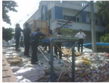
工業団地の正門付近 浸水対策で土嚢を積上げている 原材料の搬入作業中
