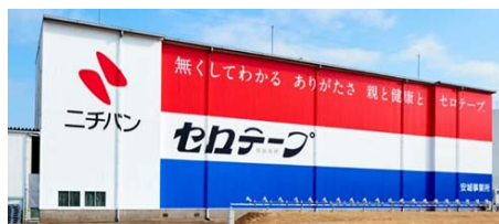
テープ安城工場 ラック倉庫サイン
