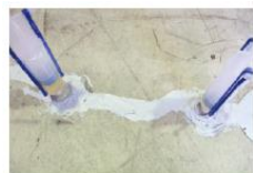
従前までの施工
