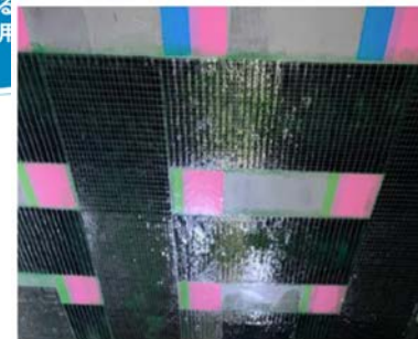
写真1. 2層目の剥離後
