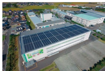
太陽光発電設備(ニチバンメディカル)
