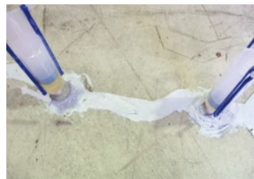
従前工法 シール材目止め+自動式低圧注入
