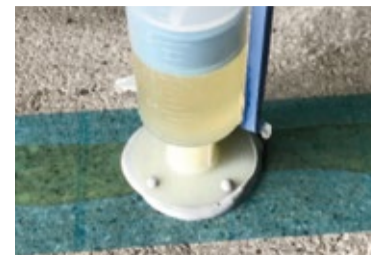
本工法 シールテープ目止め+自動式低圧注入
