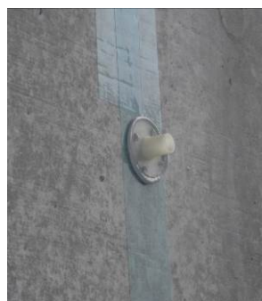
注入座金設置
