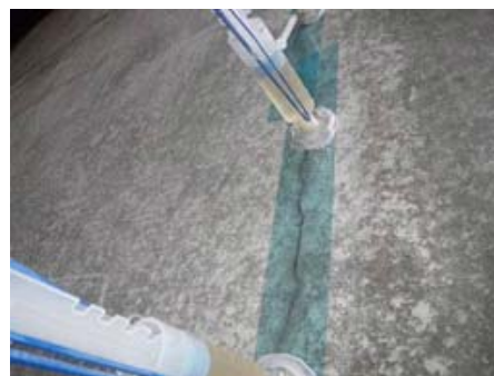
写真-2 注入状況
