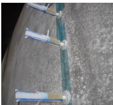
注入状況確認
